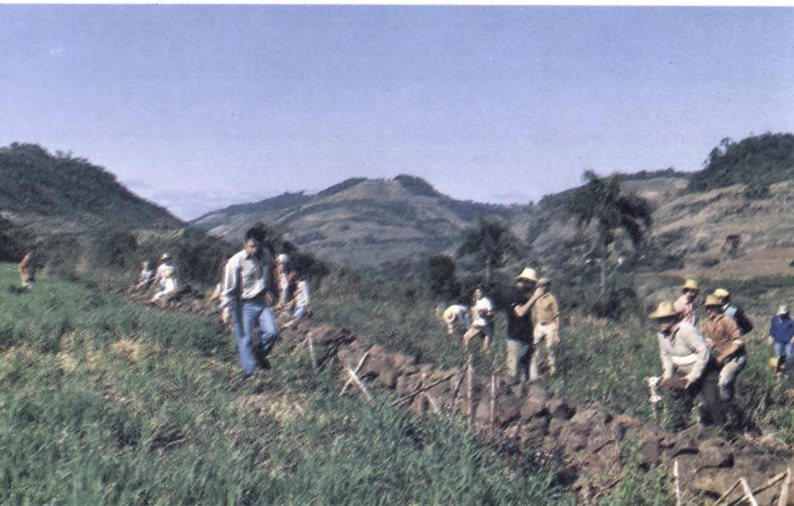
Fig. 25 - Construção de taipas de pedra na forma de mutirão.
