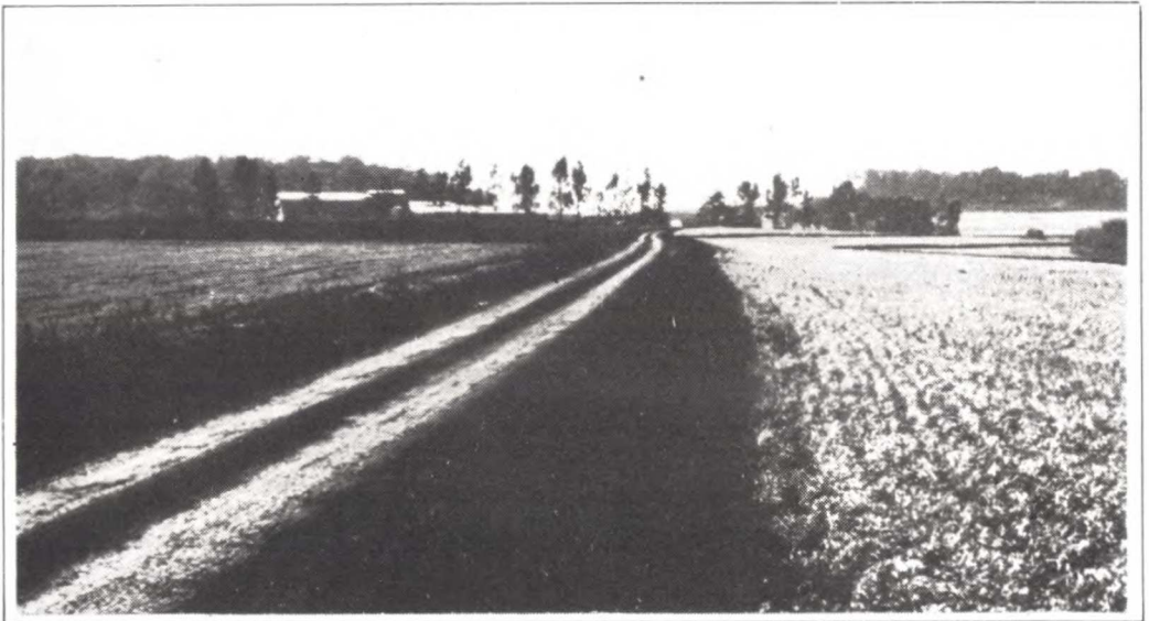
Estrada acompanhando o nível do terreno.
